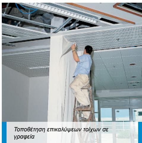
Τοποθέτηση επικάλυψων τοίχων σε ρολά με Adesilex MT32
