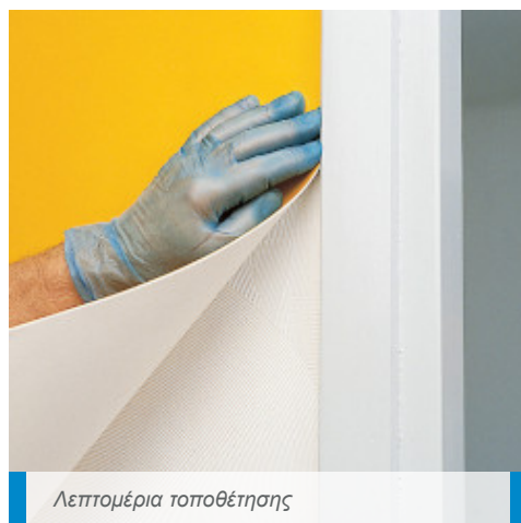
Τοποθέτηση επικάλυψων τοίχων σε ρολά με Adesilex MT32
