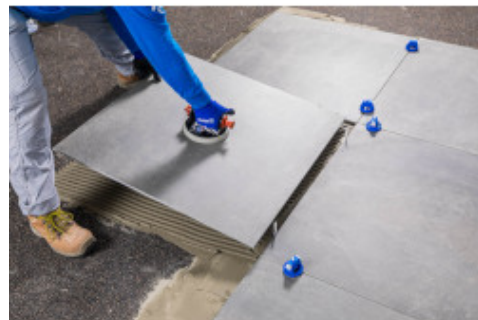
Απλώστε την κόλλα στο φύλλο Mapesonic CR και τοποθετήστε το νέο δάπεδο
