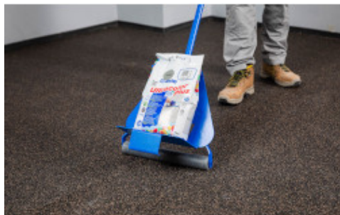
Πιέστε την επιφάνεια με σκληρό ρολό ή με επίπεδη σπάτουλα, με κίνηση από το κέντρο προς τα άκρα
