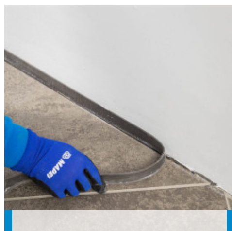
Απλώστε την κόλλα στο φύλλο Mapesonic CR και τοποθετήστε το νέο δάπεδο
