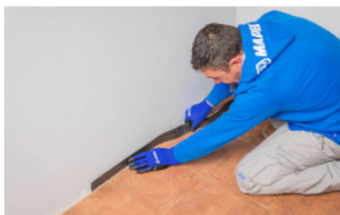
Τοποθετήστε αυτοκόλλητη ταινία Mapesonic Strip κατά μήκος της περιμέτρου του χώρου
