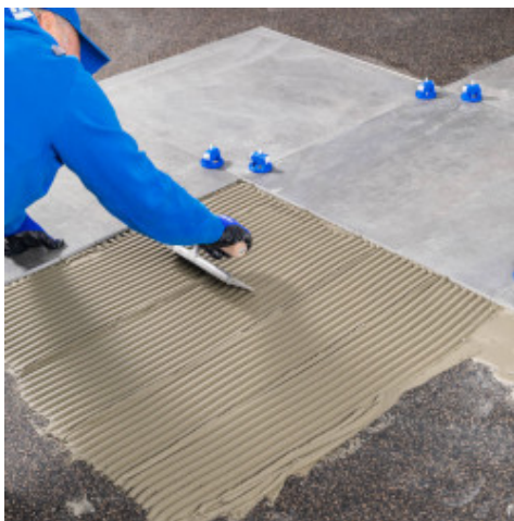
Σε κατάλληλα προετοιμασμένο υπόστρωμα, απλώστε την κόλλα για τη συγκόλληση των ηχομονωτικών φύλλων
