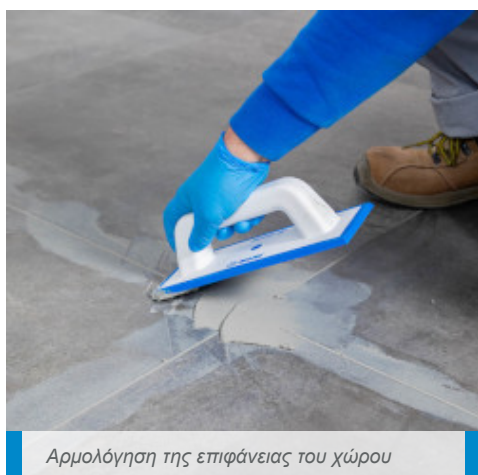
Πιέστε την επιφάνεια με σκληρό ρολό ή με επίπεδη σπάτουλα, με κίνηση από το κέντρο προς τα άκρα
