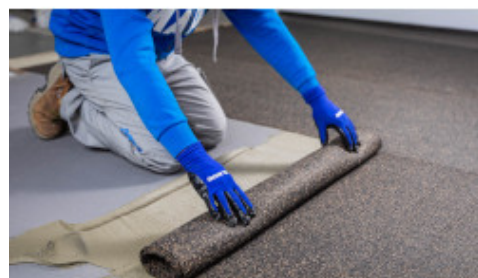
Απλώστε τα ρολά Mapesonic CR κατά μήκος της επιφάνειας φροντίζοντας τα φύλλα να τοποθετηθούν παράλληλα το ένα με το άλλο
